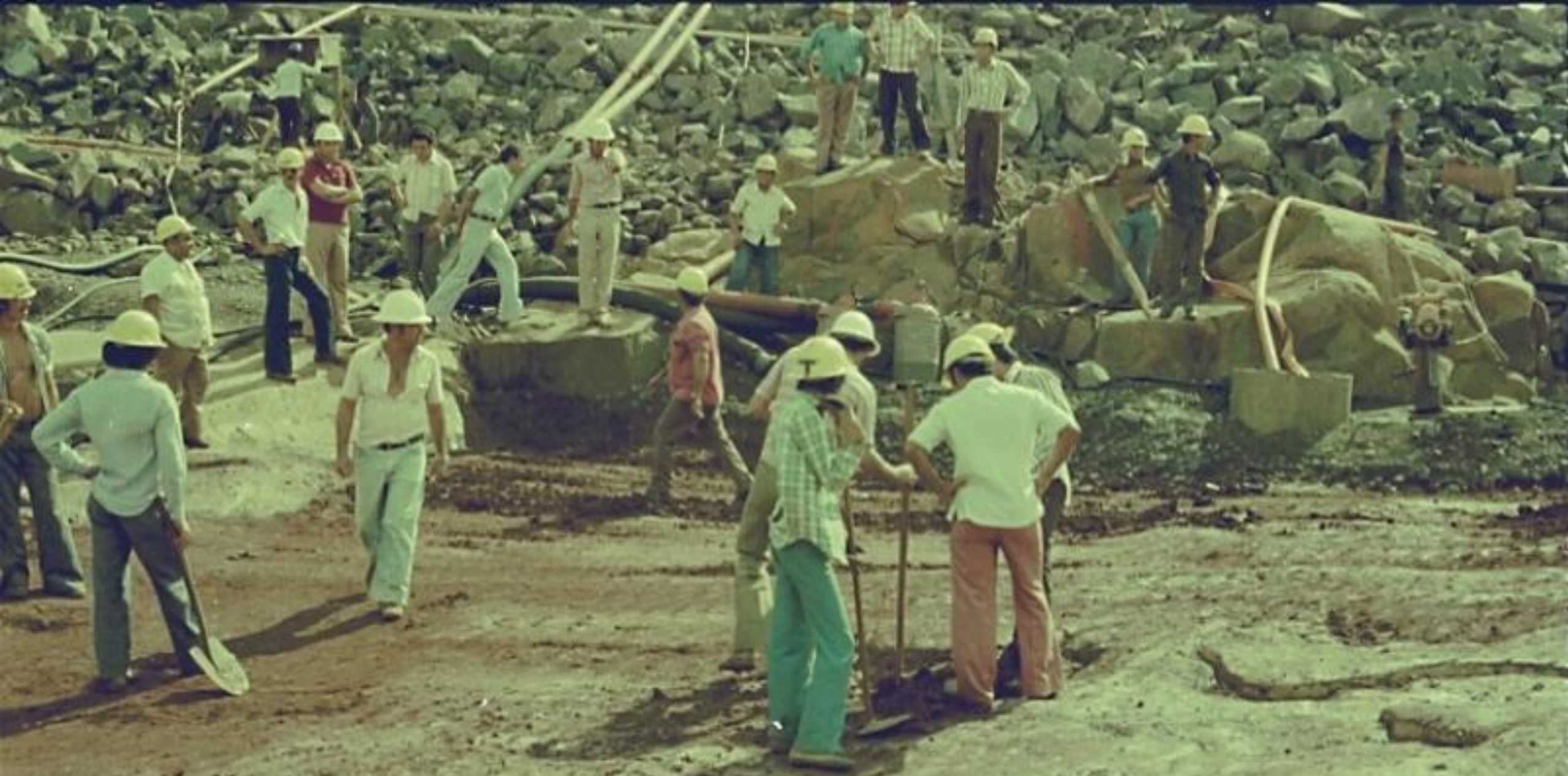
Construção da Barragem
